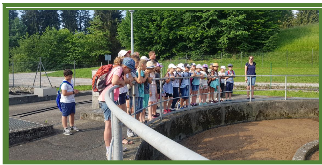
Nach dem „Sandfang“ kommt das „Belebungsbecken“
